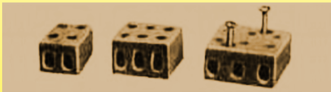
1933年高频瓷接合端子，带和不带安装孔 (Bouchery目录书, Ultimheat博物馆)
